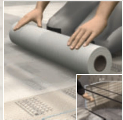
На полах и для больших поверхностей подходит широкое армирующее полотно, которое накладывается на поверхность, затем шпательюется монтажным клеящим составом.
