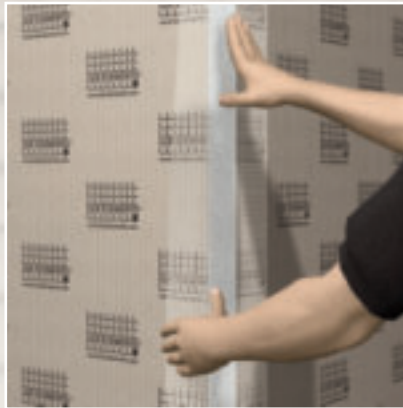
Для армирования углов используется более широкая армирующая лента.
