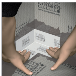
DRY-DB(V)IE – оформление внутренних углов
