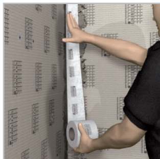
DRY-DB(V) – нанесение гидроизоляционных лент на стыки стены/пол
